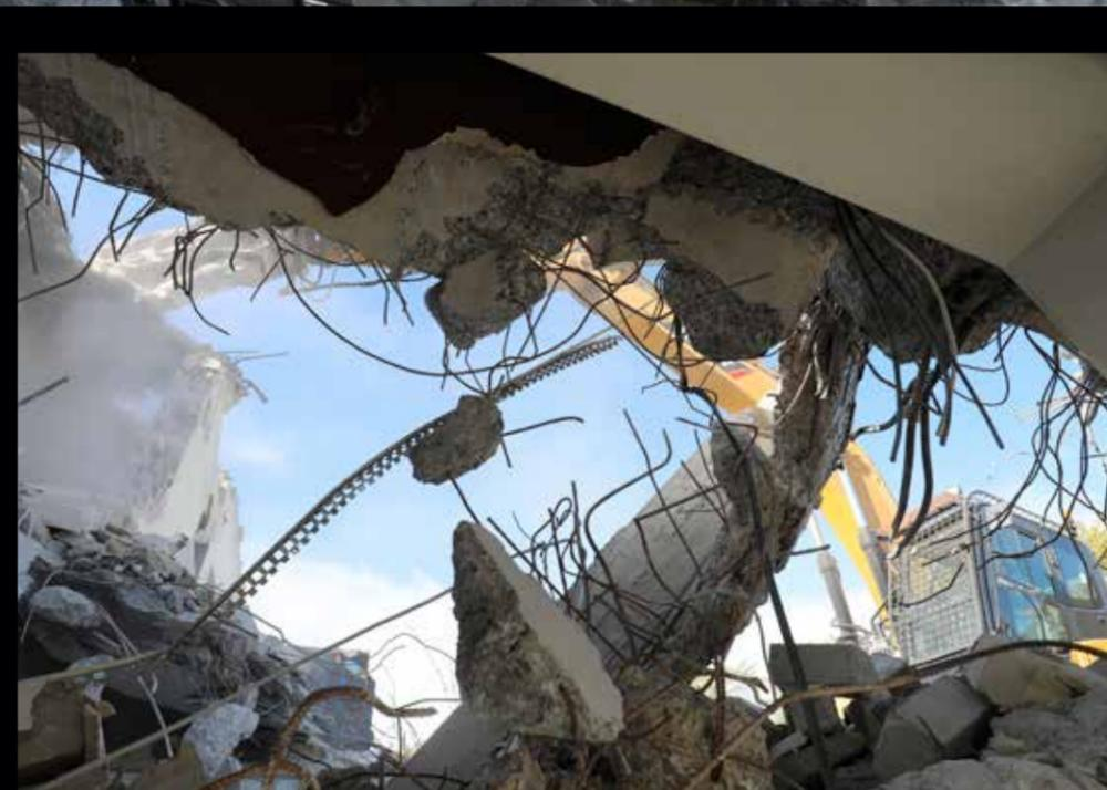
Meterhoch füllt der bislang angefallene Bauschutt das Erdgeschoss des Abrisskomplexes. Auf diesem Weg erreicht später schweres Gerät zur Sicherung der rückwärtigen Grundstücksgrenze das Innere des Gebäudes
