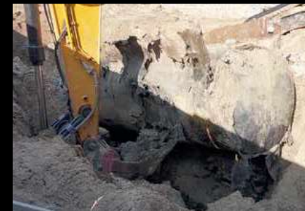
Höchstleistung: der SY265C LC wuchtet einen mit Beton gefüllten 20.000-l-Tank aus dem Erdreich
