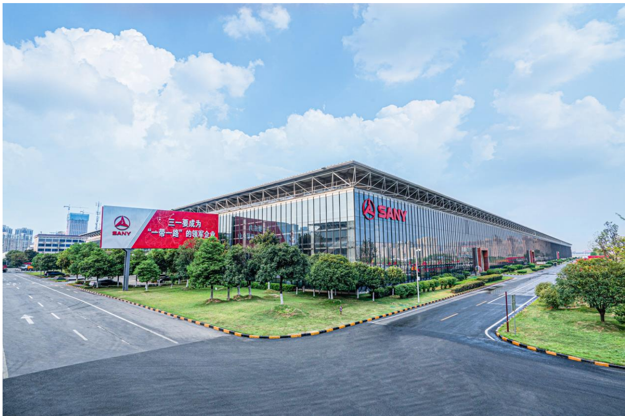
Abbildung 1: Der SANY Industrial Park Changsha
